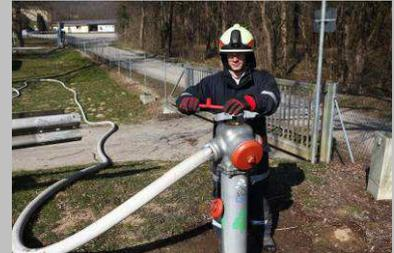
Eine Absperrung oder Zuschaltung der einzelnen Abgänge ist also ohne Bedienung der Hydrantenspindel selbst nicht möglich.
