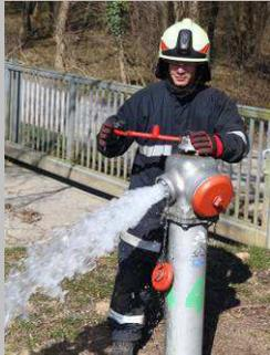
Mit Hilfe eines Überflurhydrantenschlüssels werden zunächst die Deckkapseln entfernt. Anschließend wird der Überflurhydrantenschlüssel an der Haubenspitze angesetzt. Durch Linksdrehen der Hydrantenspindel wird das Absperrventil geöffnet und der Hydrant gespült. Danach wird er wieder geschlossen und der Druckschlauch angeschlossen. Bei geöffnetem Hydrantenventil steht an allen Abgängen Wasser an.
